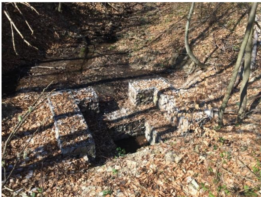
Úprava pred priepustom: Obec Bodružal
